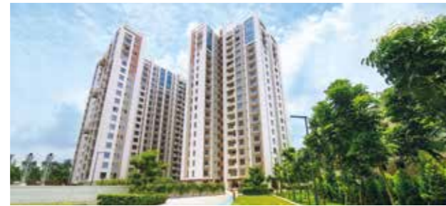
Ozone, South EM Bypass
